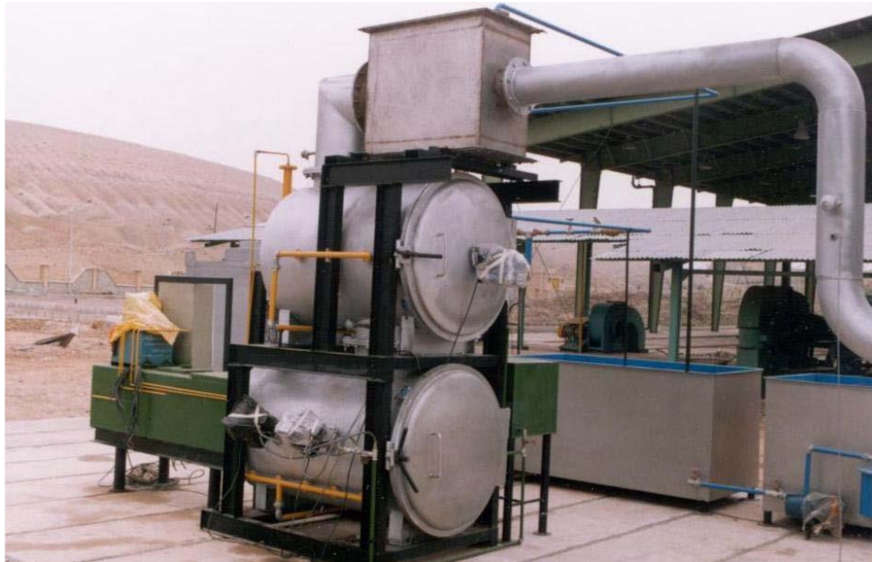
پایلوت زباله‌سوز نصب شده در کارخانه کمپوست کرج
